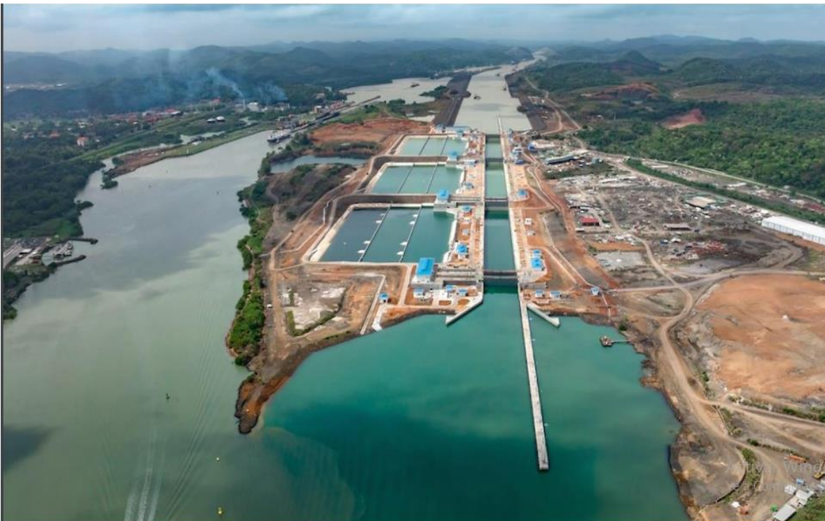
Ilustración 6 Motor de crecimiento en construcción 2
