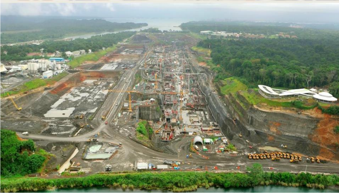
Ilustración 5 Motor de crecimiento en construcción 1
