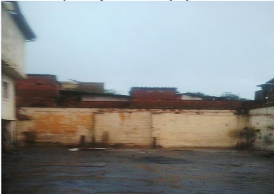
Figura 6 Espacio interno del parqueadero
