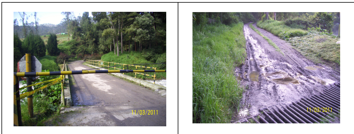
Ilustración 1: Secuencia fotográfica del estado actual de la carretera en estudio
