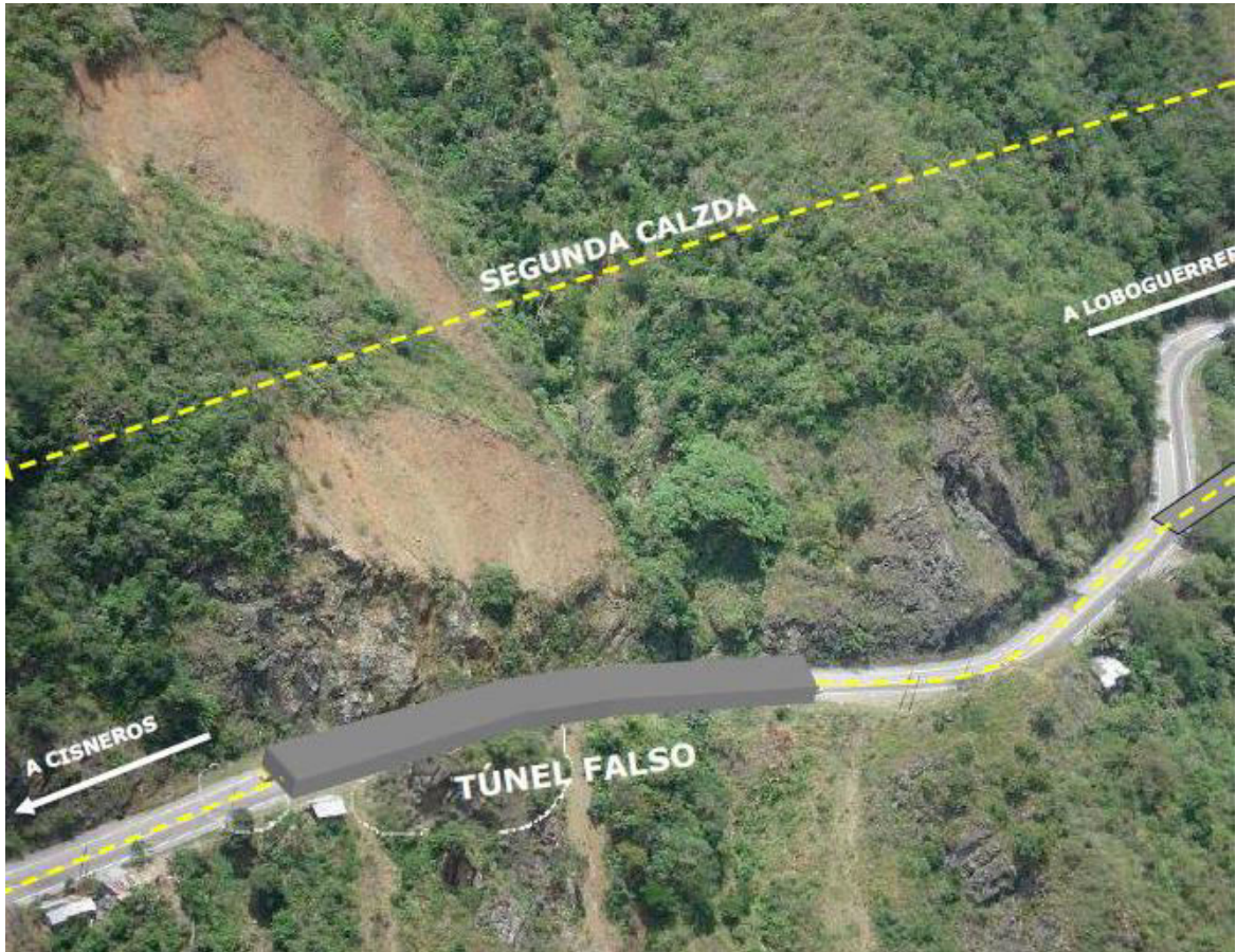
Figura 22. Estado actual obras de la doble calzada Buga–Loboguerrero–Buenaventura
