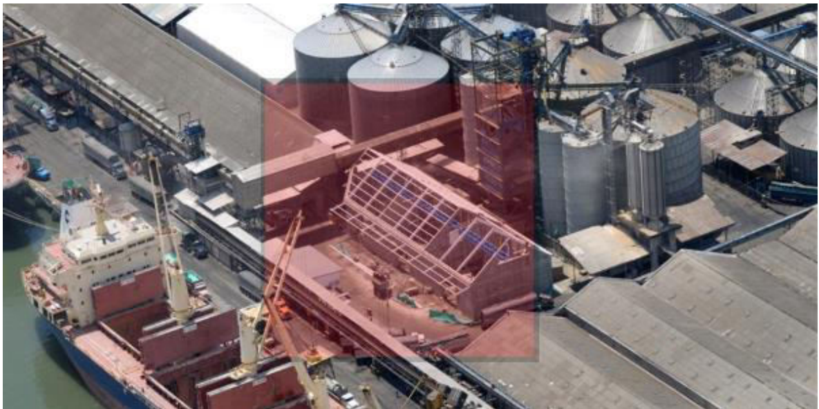
Figura 19. Obras en la bodega E
