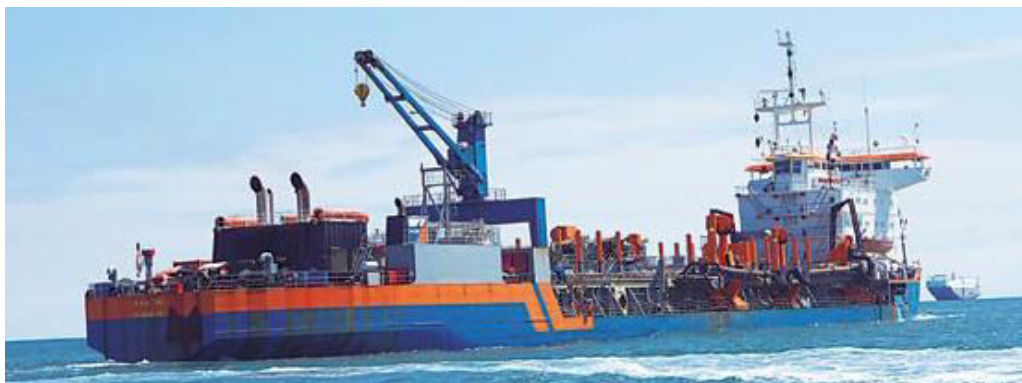
Figura 16. Obras de dragado en el Puerto de Buenaventura
