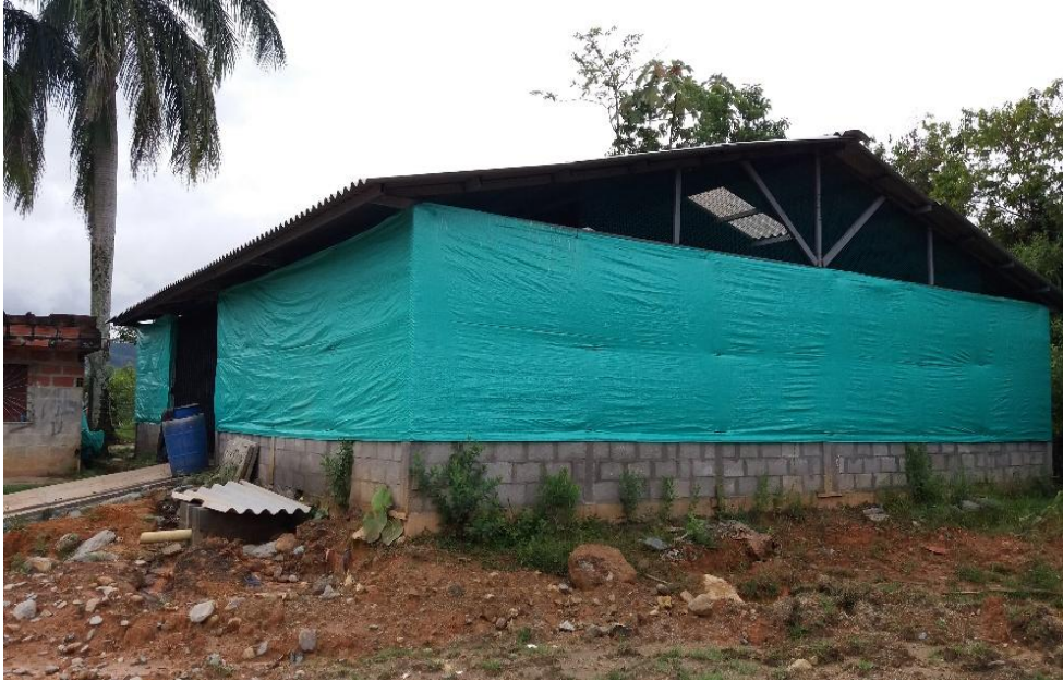
Figura 12. Infraestructura, planta generadora de compost
