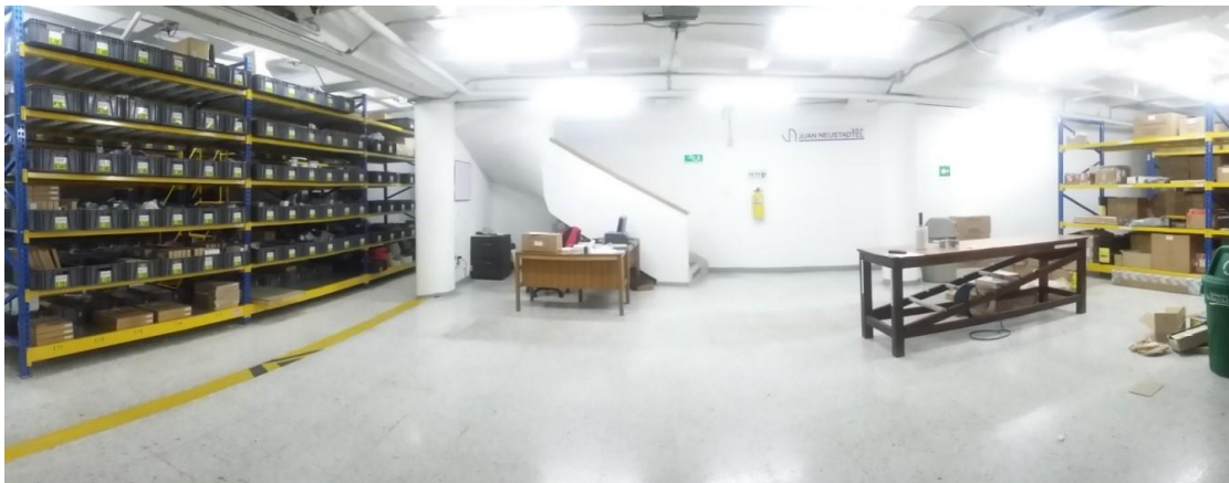
Figura 44. Bodega de repuestos
