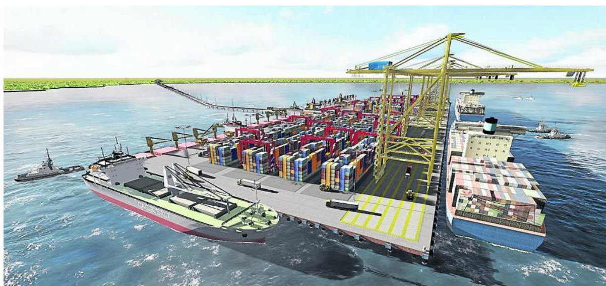
Ilustración 9 Plataforma de carga sobre el Mar.
