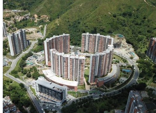
Figura 20. Foto aérea general de la zona
