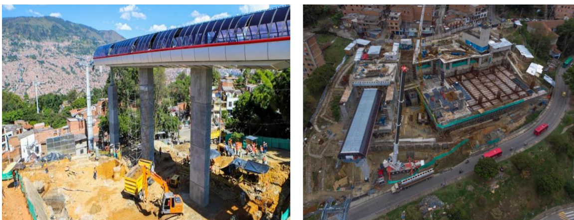
Figura 17 Construcción estación de Metrocable Picacho. (Recuperado de https://www.medellin.gov.co/irj/portal/medellin?NavigationTarget=navurl://a43bb461be5f2fdb24cedbed3341a881 , julio 2020).
