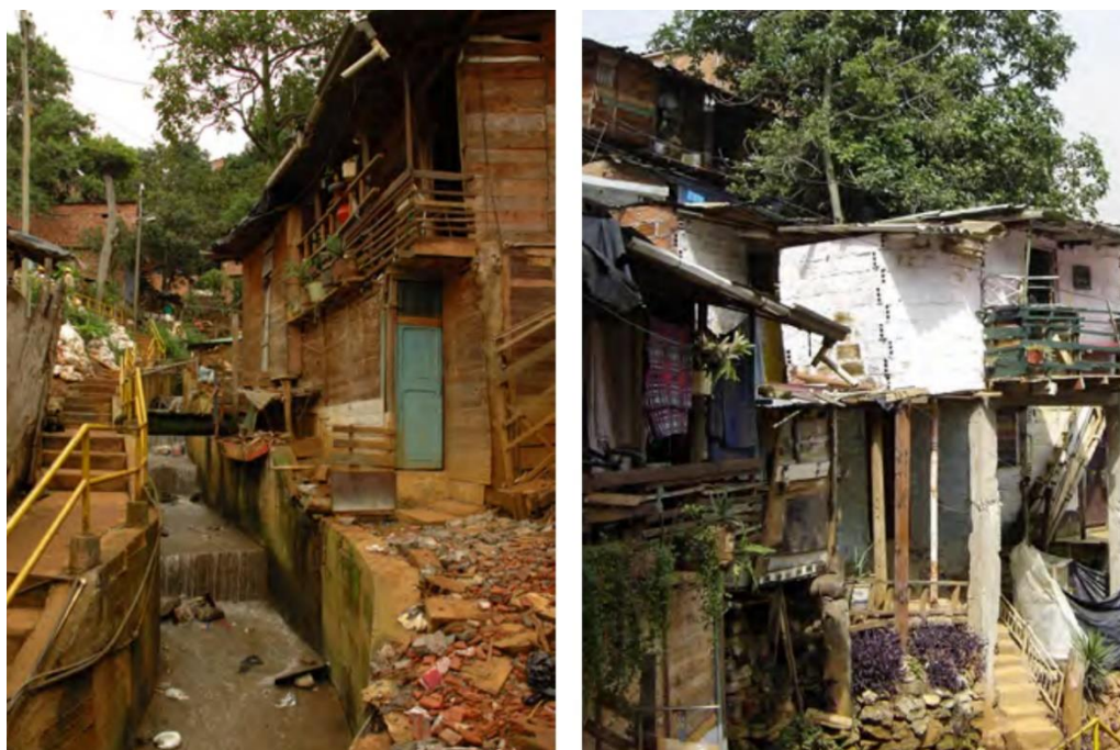
Figura 46 Conjunto de fotos de la quebrada Juan Bobo demostrando las condiciones inadecuadas de las viviendas y del espacio público antes de la intervención. (Recuperado de http://www.eafit.edu.co/centros/urbam/articulos-publicaciones/Documents/urbam%20EAFIT%202013%20Sistematizacion_Urbanismo_Social_Espa%C3%B1ol_.pdf , julio 2020)
