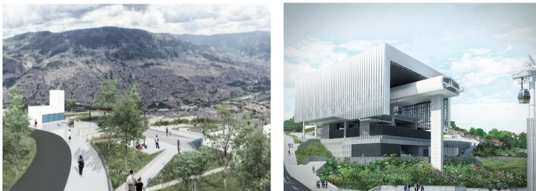
Figura 16 Proyecto Metrocable Picacho.. (Recuperado de https://www.metrodemedellin.gov.co/al-d%C3%ADa/noticias-metro/artmid/6905/articleid/394/en-2018-se-ver225n-avances-del-metrocable-picacho , julio 2020).
