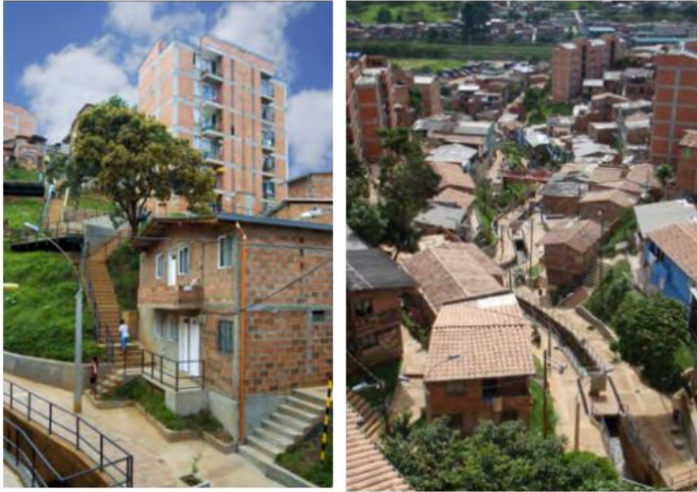
Figura 47 Conjunto de fotos de la construcción de tipología de edificios construida e intervención integral de colectores de aguas residuales. (Recuperado de http://www.eafit.edu.co/centros/urban/articulos-publicaciones/Documents/urban%20EAFIT%202013%20Sistematizacion_Urbanismo_Social_Espa%C3%B1ol_.pdf , julio 2020)
