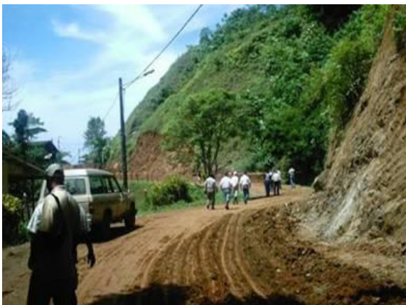
antes en construcción
