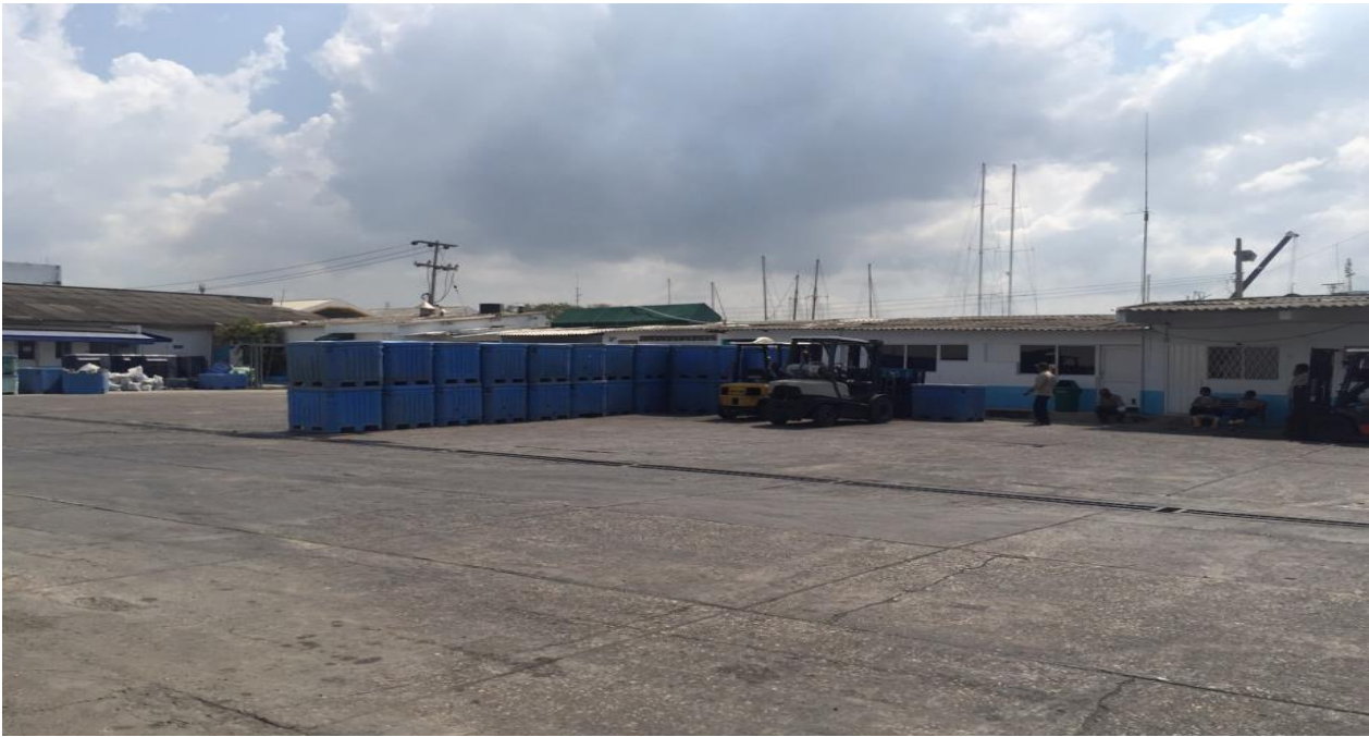
ILUSTRACION No 9: Empresa C.I OCÉANOS
