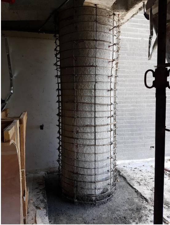
Ilustración 7 Colocación de acero de refuerzo en columna de repotenciación obra Art Living
