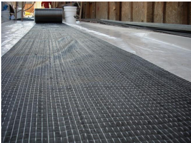
Ilustración 4 Presentación del tejido de fibra de carbono (Tecnoav, 2012)
