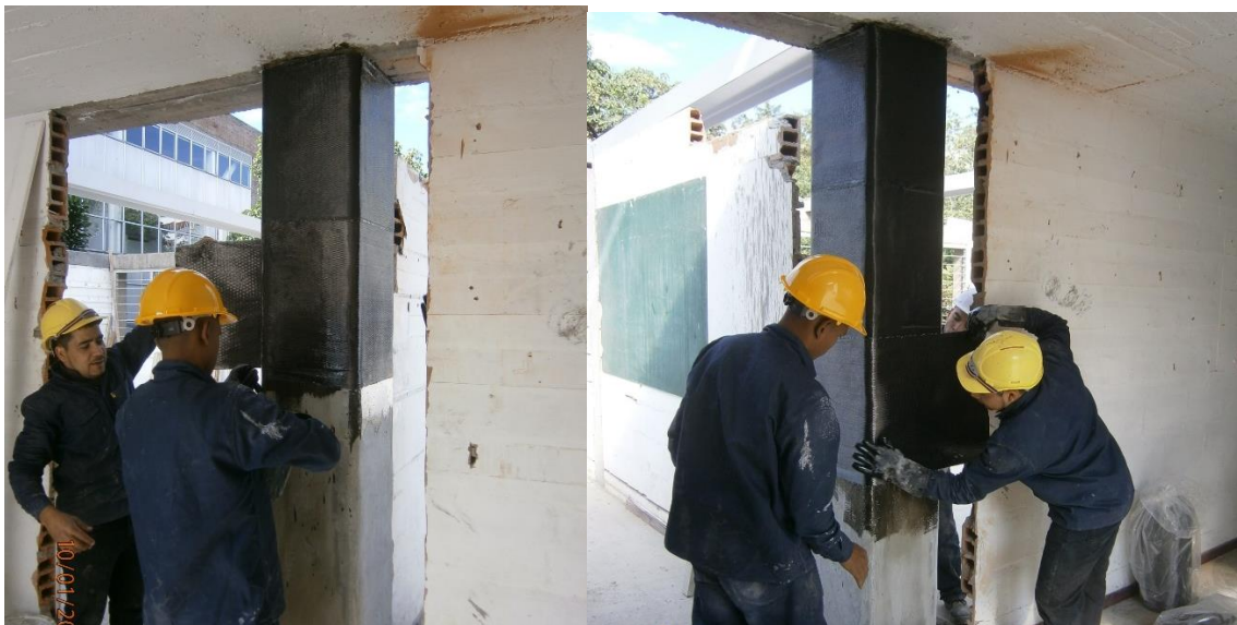
Ilustración 5 Repotenciación con fibra Bloque 10B UPB. Recubrimiento con fibra de carbono de la columna a intervenir.
