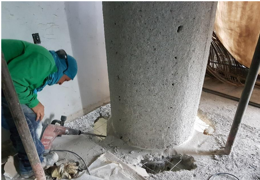
Ilustración 6 Abujardada de columna para aplicar adherente concreto-concreto obra Art Living
