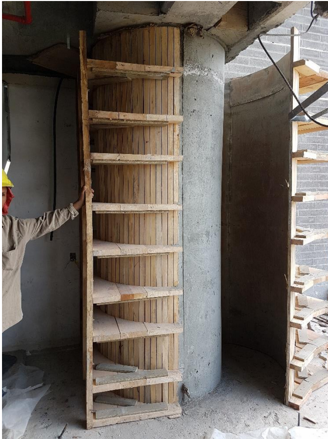
Ilustración 9 Concreto vaciado y proceso de retirar obra falsa-Art Living
