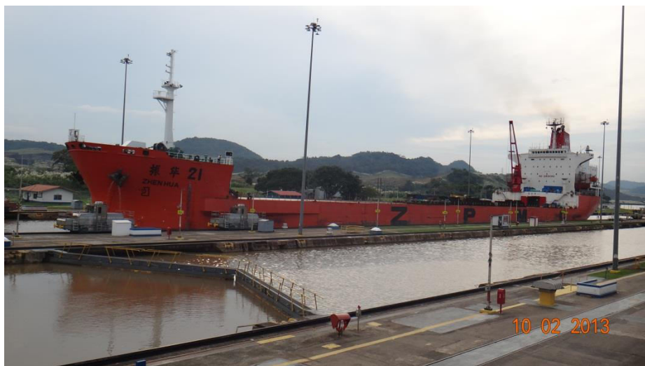
Figura 8. Vaciado de Esclusa Miraflores
