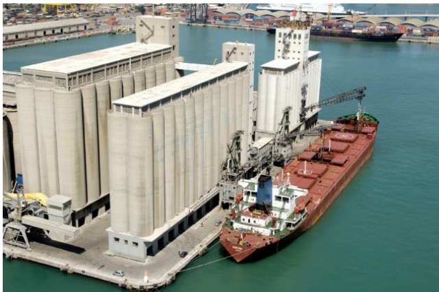
Figura 6. Terminal de granel sólido
