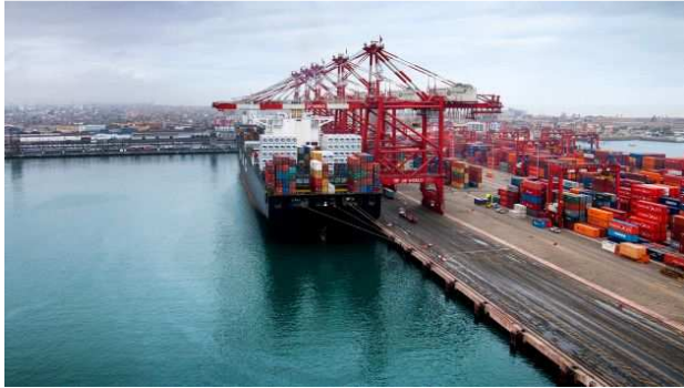
Figura 4. Terminal de contenedores
