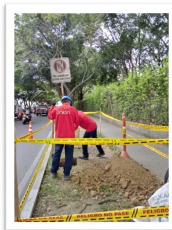
Figura 7. Actividades en Calle para Instalación de estructuras
