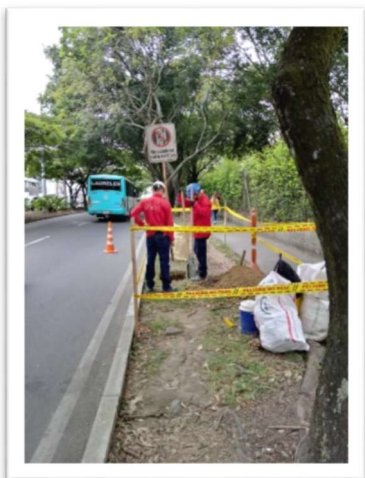
Figura 6. Actividades en Calle para Instalación de estructuras
